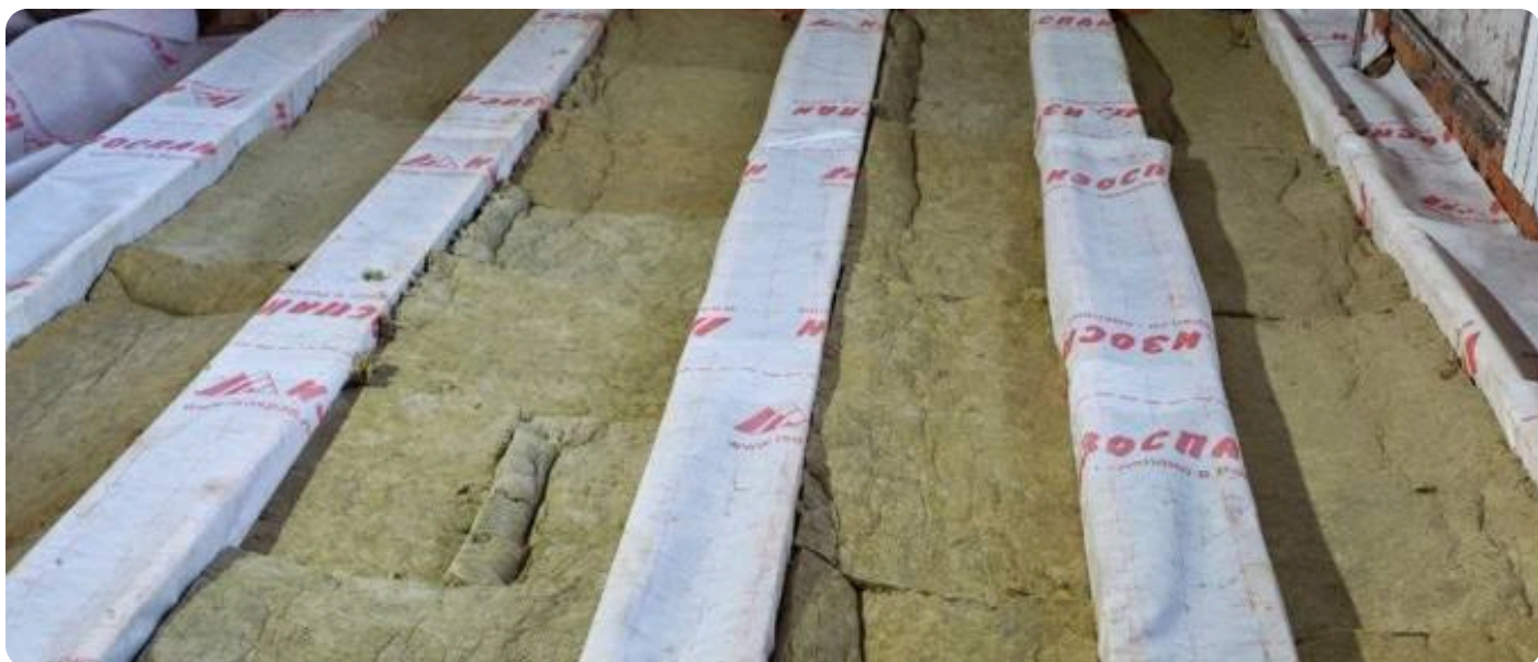
Сталинка: деревянные перекрытия вскрыты, утепление и новый пирог пола
