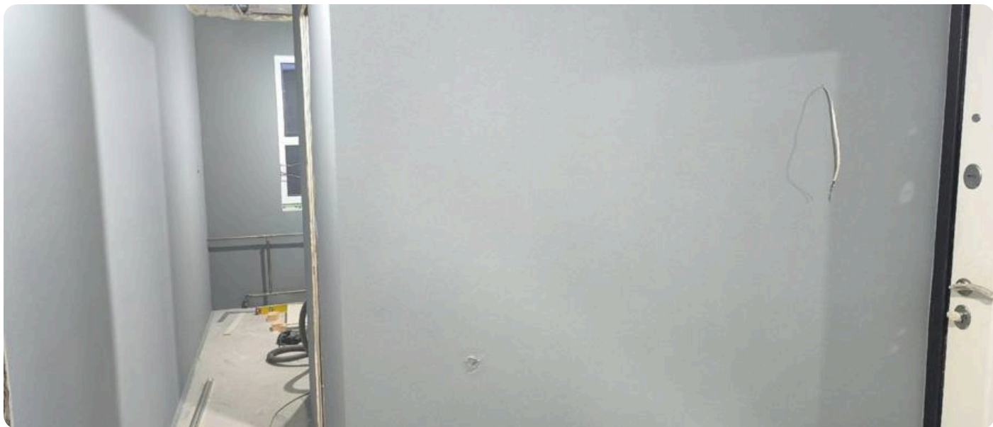
Стены по маякам: допуск 2 мм на 2 метра проверяется правилом
