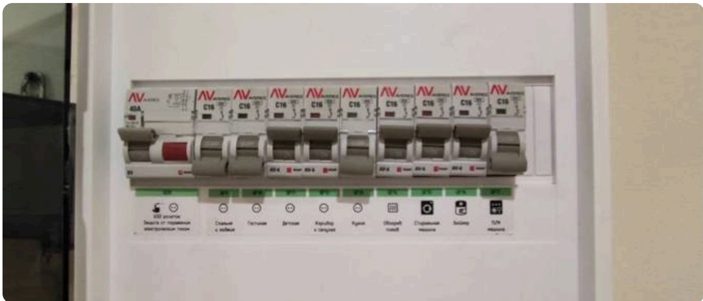
Собранный щит: автоматы по группам, УЗО, реле напряжения, каждая линия подписана
