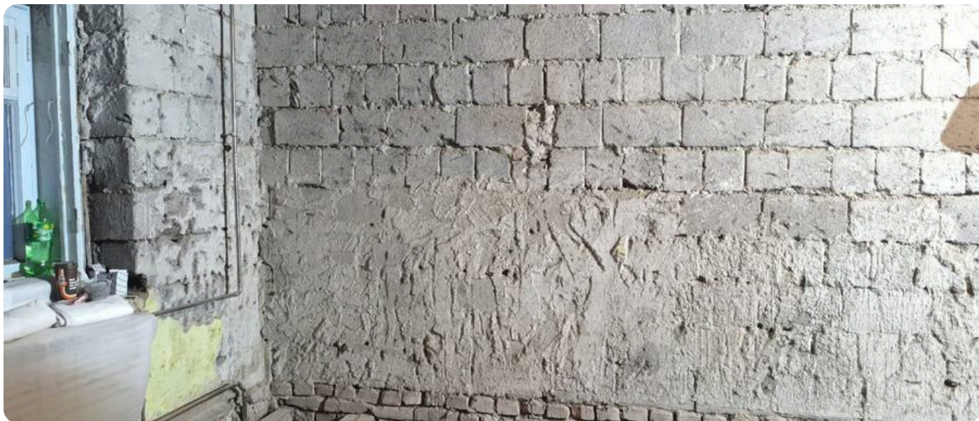
После демонтажа: кирпич сталинки, старая штукатурка снята до основания
