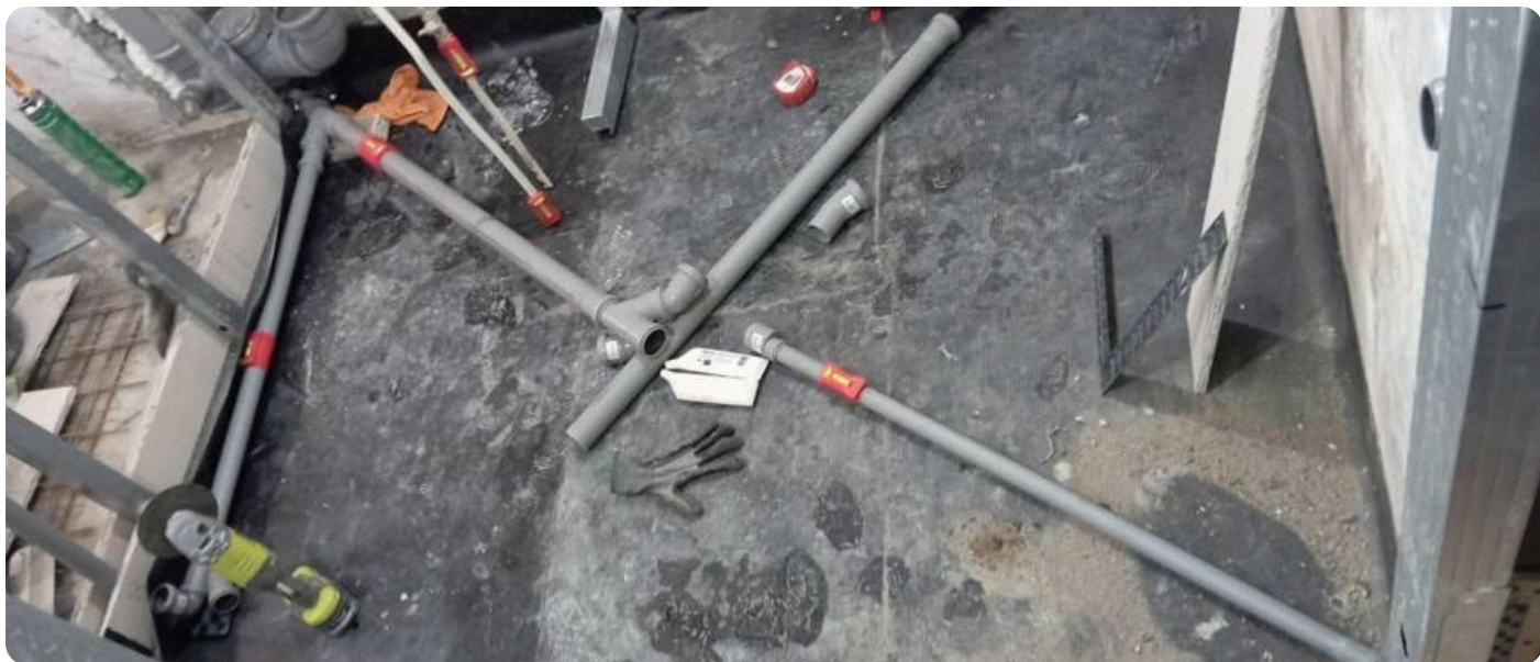
Демонтаж сантехкабины в панельной девятиэтажке
